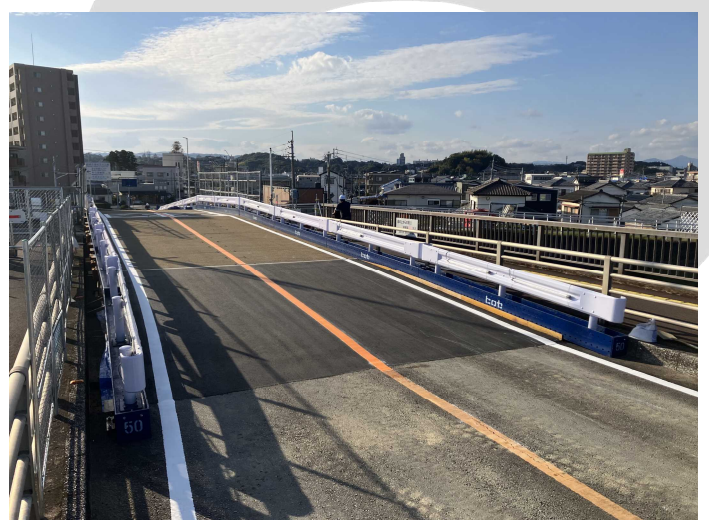
【大塚町側の仮設道路状況】
